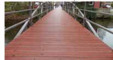
Brückenbelag aus TRIMAX®
