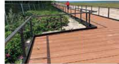
Steg am Strand aus TRIMAX®
