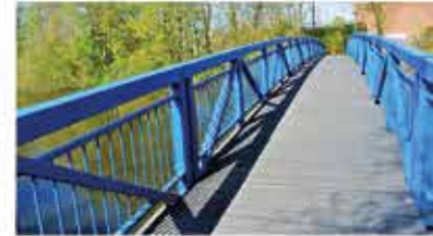
TRIMAX® als Brückenbelag
