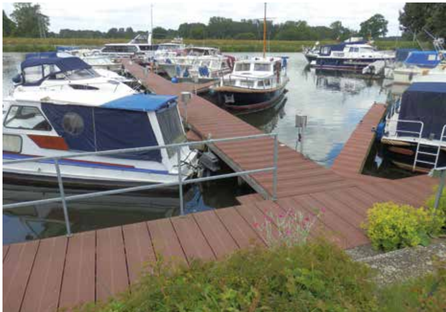
Hohe Lebensdauer, verrottungsfest und recyclebar – die TRIMAX®-Bohlen aus HDPE-Kunststoff von Tepro sind eine echte Alternative im Stegebau.
